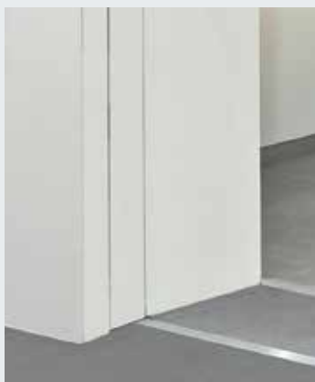
Kłapa do niszy przy otwartej bramie
