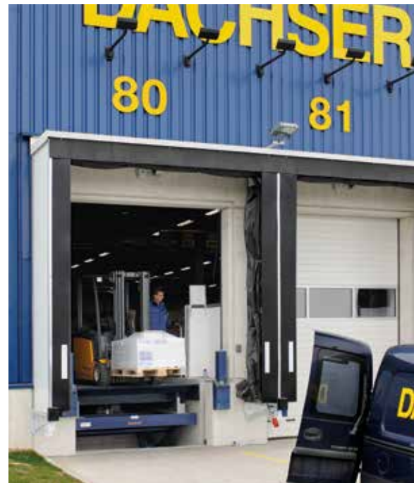
Liftableller jest połączeniem rampy przeładunkowej z wysuwaną klapą i podnośnika nożycowego
